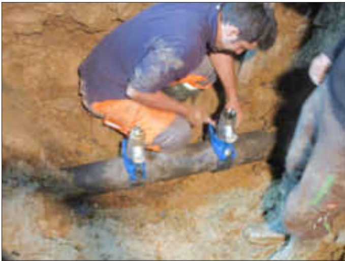
Wasserwart Michael Villa bei den Arbeiten an der Hauptleitung und der Installation der beiden neuen Hausschieber.
