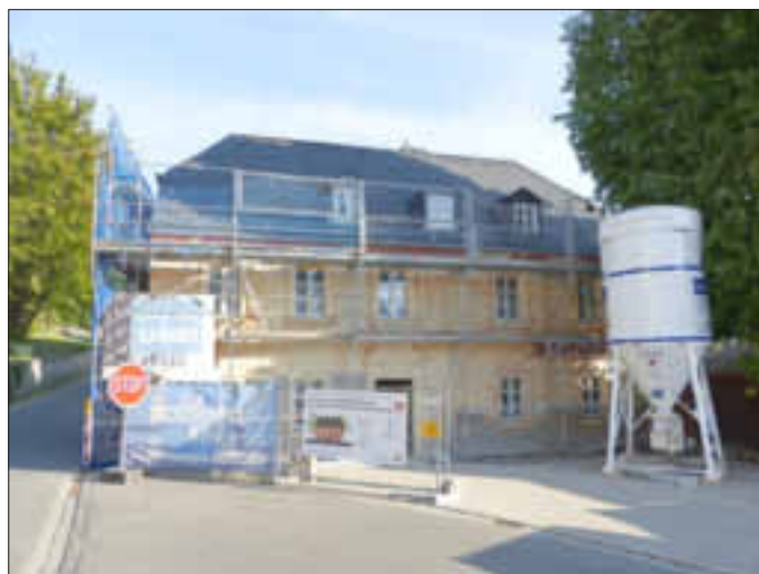
Unser Bild zeigt das im Umbau befindliche Haus in Grafengehaig, Marktplatz 1, das zum künftigen Dorfgemeinschaftshaus hergerichtet wird.
