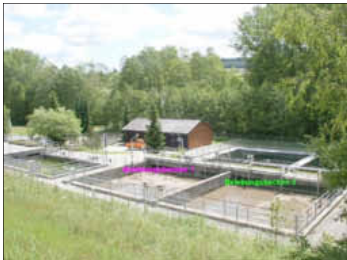
Kläranlage der Marktgemeinde Marktkeugast in der Weiermühle in Marienweiher.
